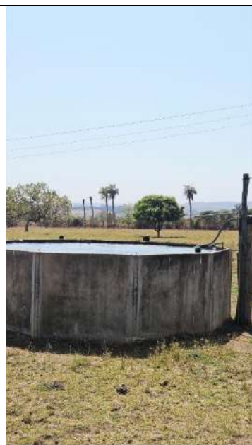
Reservatório grande de água
