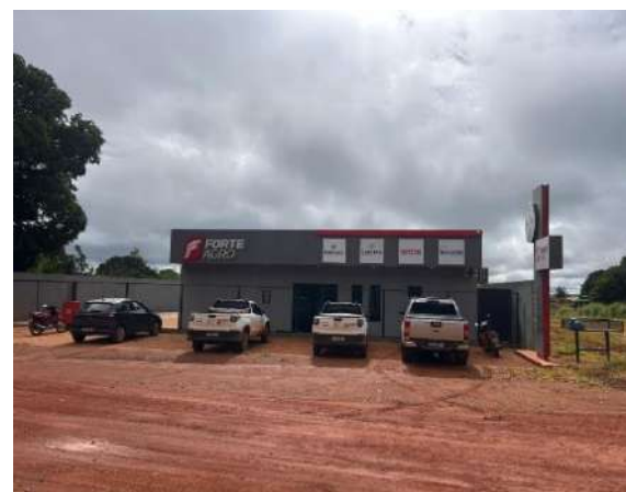
Visão Geral – Fachada
