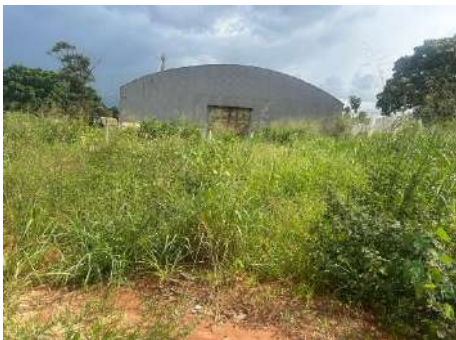
FOTO 3. Visão Geral - Externa.
