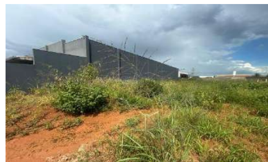
FOTO 6. Visão Geral - Externa.
