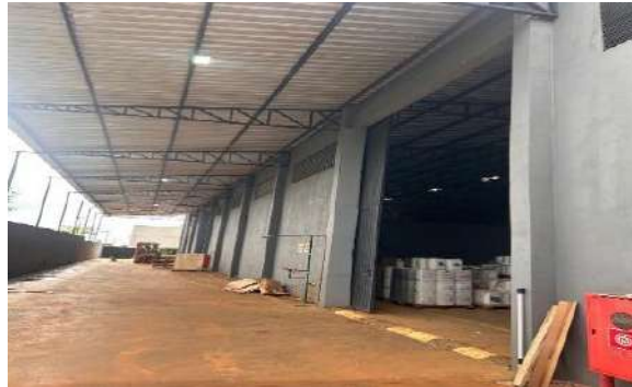
Visão Galpão – Externa
