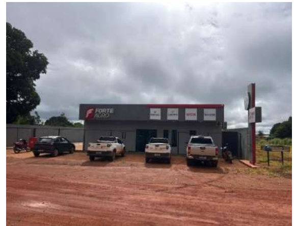
Visão Geral – Fachada
